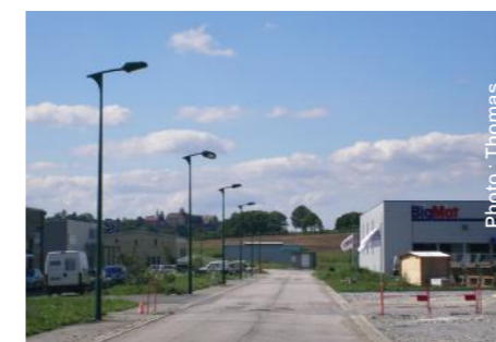
Les travaux débuteront en mars 2018
